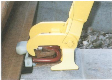
图 G.2 弹条安装示意
